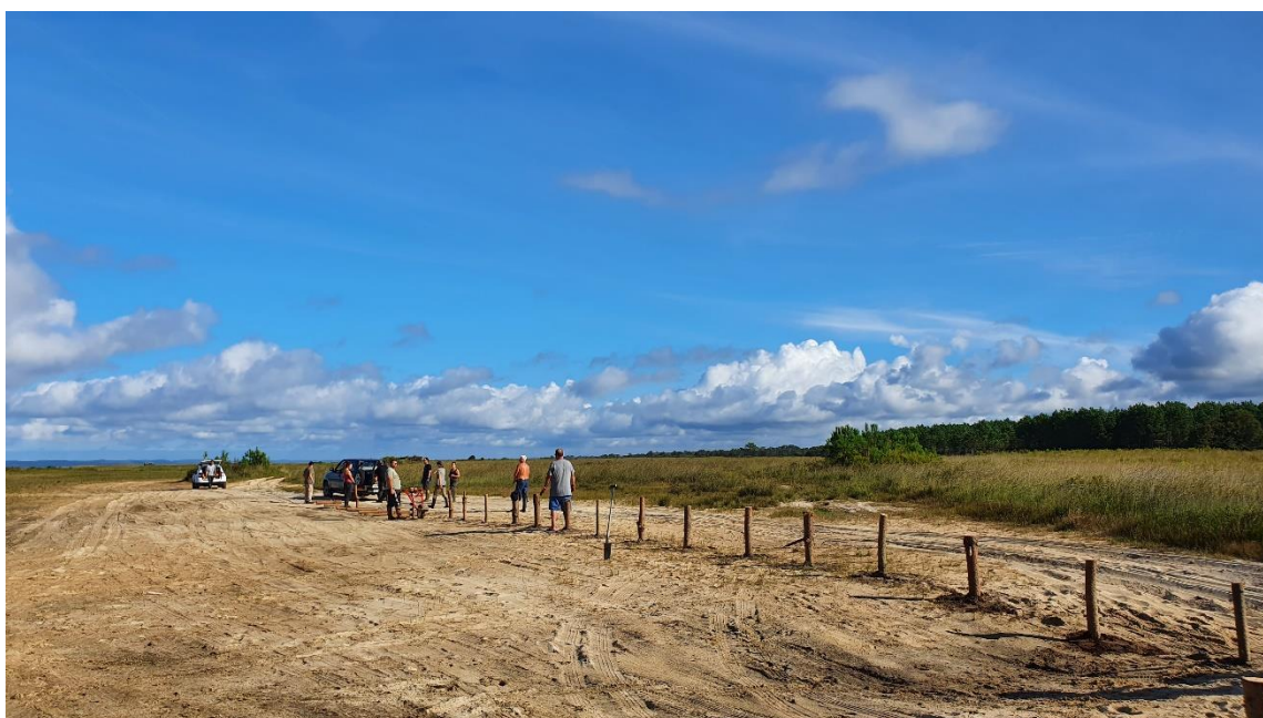
Figure 5 : chantier de pieutage sur les rives de Hourtin-Carcans (© CBNSA – S. Lorient, 2022)
